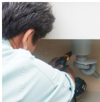
【流し台入れ替え作業の様子です】
